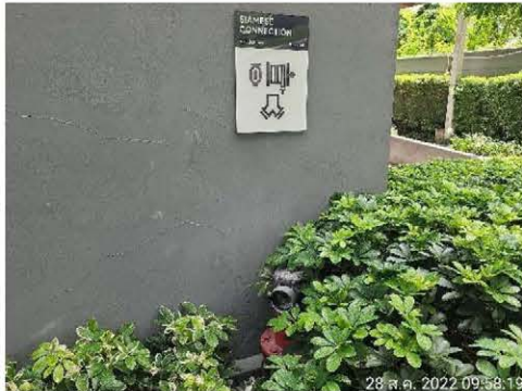
ภาพที่ 2-53 หัวรับน้ำดับเพลิงภายนอกอาคาร (Fire Department Connector : FDC)
