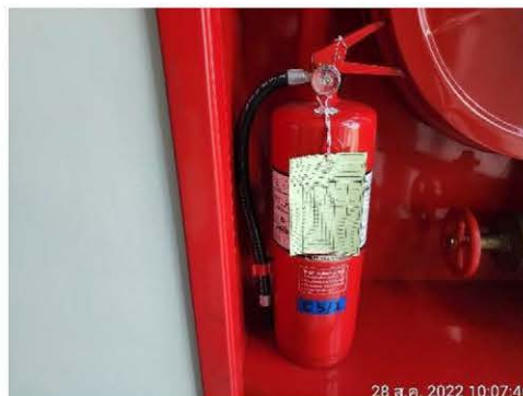
ภาพที่ 2-55 ถังดับเพลิงแบบมือถือ ขนาด 10 ปอนด์ ติดตั้งภายในตู้ FHC ทุกตู้
