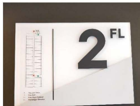
ภาพที่ 2-64 แผนผังแสดงรายละเอียดตำแหน่งบันไดหนีไฟ อุปกรณ์ระงับอัคคีภัย ทางเดิน และเส้นทางอพยพหนีไฟ ไว้บริเวณโถงลิฟต์ทุกชั้นของอาคาร
