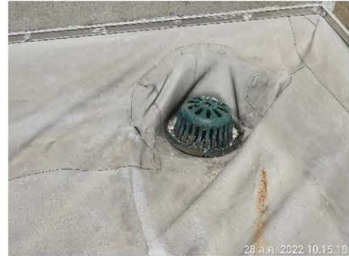
ภาพที่ 2-79 ตะแกรงครอบตามรูท่อระบายน้ำ
