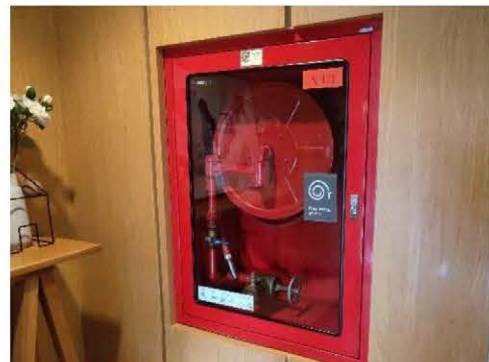
ภาพที่ 2-54 ตู้สายฉีดน้ำดับเพลิง พร้อมอุปกรณ์ (Fire Hose Cabinet : FHC)
