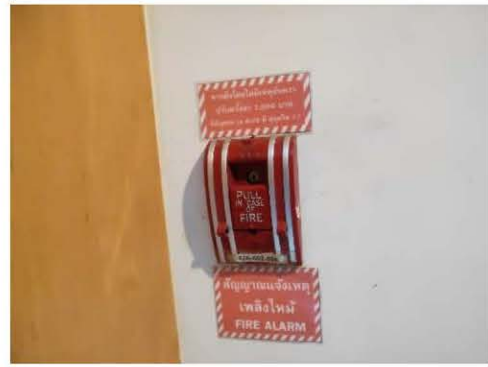
ภาพที่ 2-60 เครื่องแจ้งเหตุเพลิงไหม้แบบมือกด (Manual Station) บริเวณโถงบันได และโถงลิฟต์
