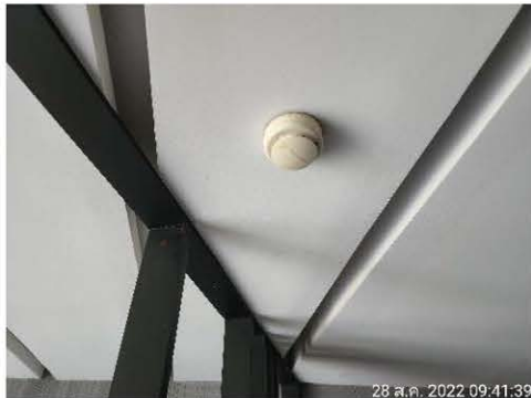
ภาพที่ 2-58 เครื่องตรวจจับควัน (Smoke Detector)
