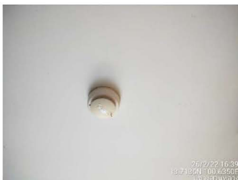
ภาพที่ 2-59 เครื่องตรวจจับความร้อน (Heat Detector)
