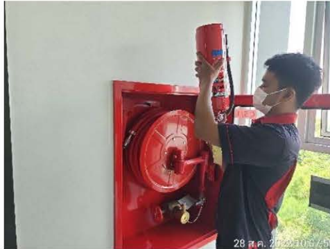
ภาพที่ 2-17 เจ้าหน้าที่ตรวจสอบถังดับเพลิงเคมี
