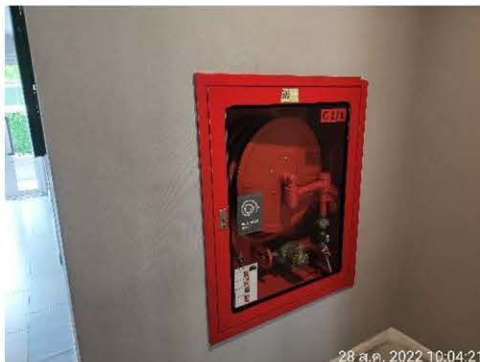
ภาพที่ 2-54 ตู้สายฉีดน้ำดับเพลิง พร้อมอุปกรณ์ (Fire Hose Cabinet : FHC)
