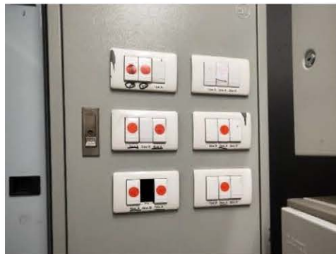
ภาพที่ 2-46 สวิตช์ควบคุมอุปกรณ์ไฟฟ้าแสงสว่างแบบแยกส่วน
