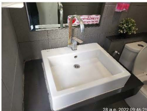
ภาพที่ 2-23 เลือกใช้สุขภัณฑ์ประหยัดน้ำและมีประสิทธิภาพสูงทั้งก๊อกน้ำ ชักโครก และหัวฉีดน้ำ
