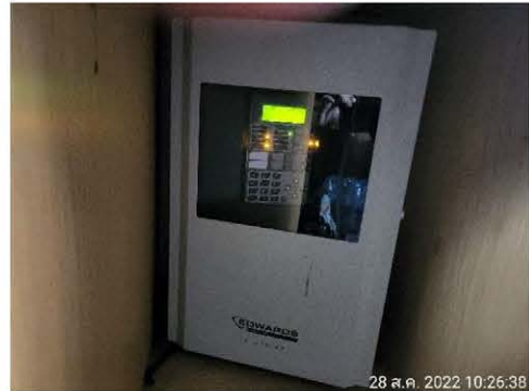
ภาพที่ 2-57 แผงควบคุม (Fire Alarm Control Panel : FCP)
