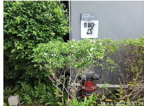
ภาพที่ 2-53 หัวรับน้ำดับเพลิงภายนอกอาคาร (Fire Department Connector : FDC)
