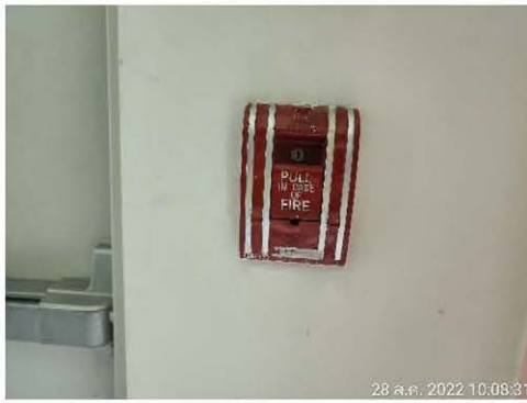
ภาพที่ 2-60 เครื่องแจ้งเหตุเพลิงไหม้แบบมือกด (Manual Station) บริเวณโถงบันได และโถงลิฟต์
