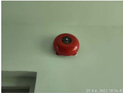
ภาพที่ 2-61 เครื่องแจ้งเหตุเพลิงไหม้ด้วยเสียง (Alarm Bell)
