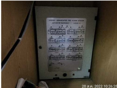
ภาพที่ 2-57 แผงควบคุม (Fire Alarm Control Panel : FCP)
