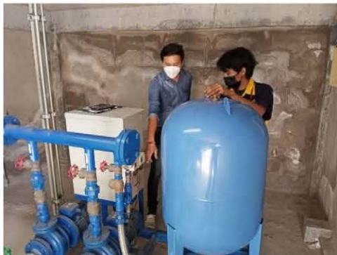
ภาพที่ 2-72 ตรวจสอบความสะอาดถังเก็บน้ำ
