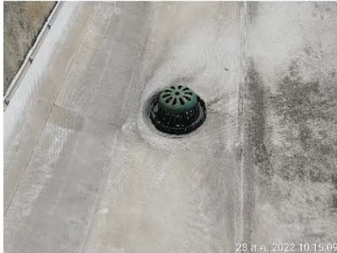
ภาพที่ 2-79 ตะแกรงครอบตามรูท่อระบายน้ำ
